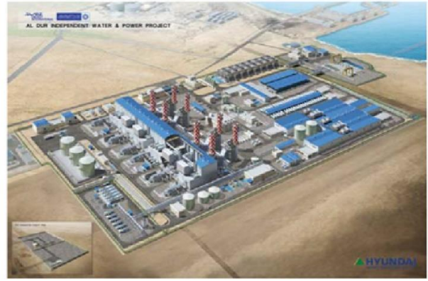
ALDUR IWPP PROJECT
